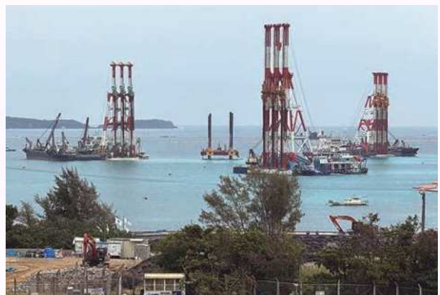
港湾施設予定地で進む砂杭打設
